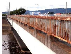
豊川放水路 1987年12月完成
